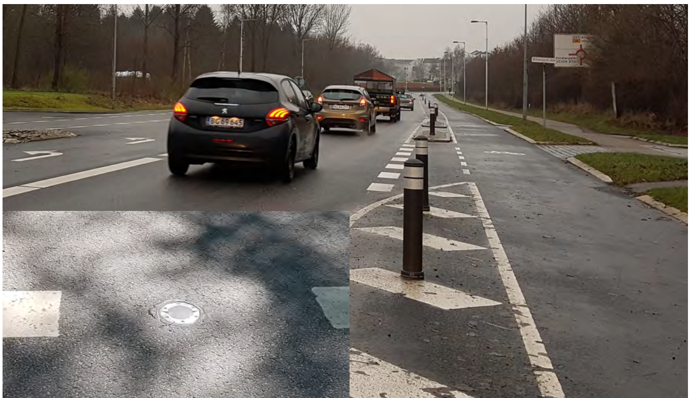
Stort foto: Eksempel på forstærket skillerabat med steler på Frederiksborgvej i Hørsholm Kommune.
